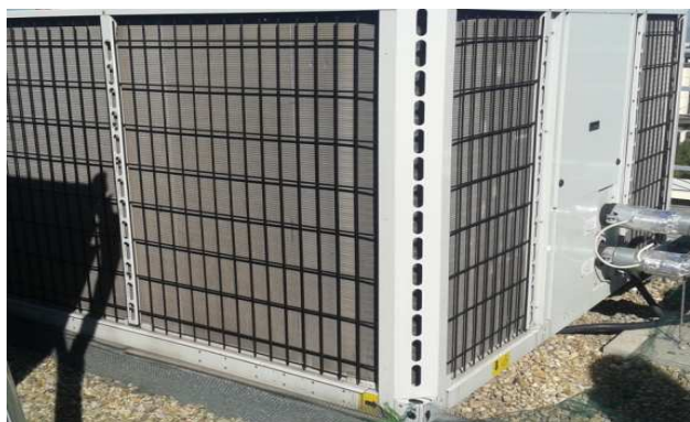
Фиг. 3а Изглед на тяло на вентилационна система (звукова мощност на 1 м - 55-65)
